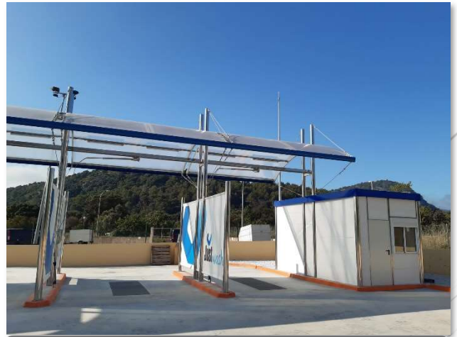
Centro de lavado de vehículos
