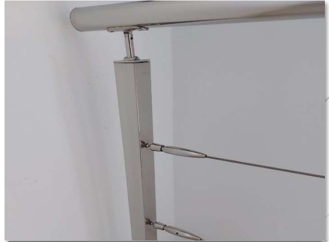
Barandilla inox con cables tensores
